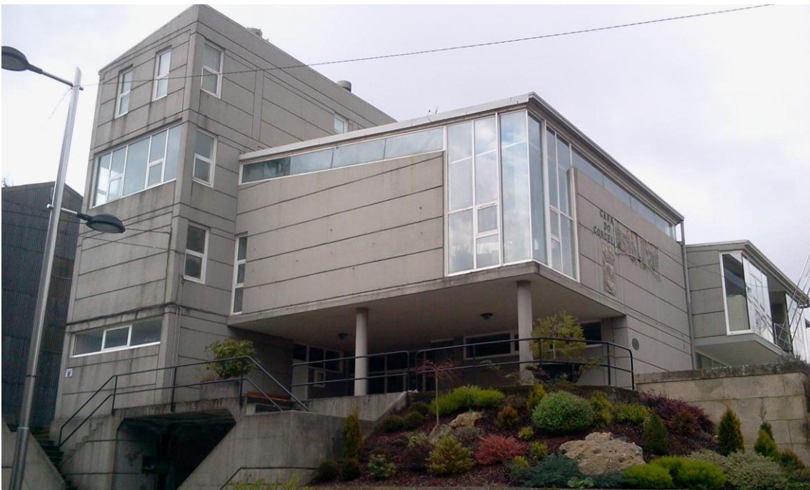
Vista lateral Oeste de corpo principal e posterior.
