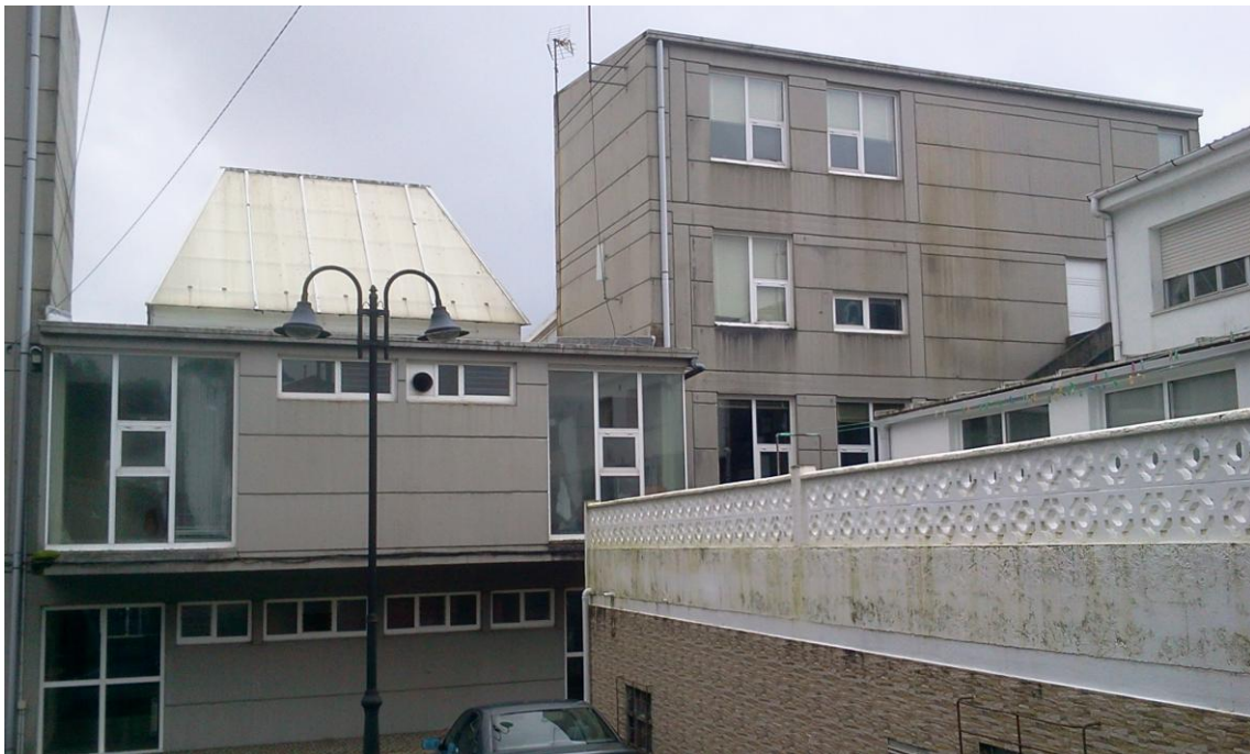
Vista do lucernario e faldóns a norte.
