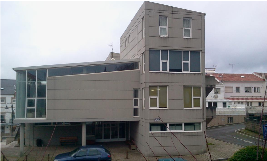
Vista a Leste de faldóns de corpo principal e posterior.
