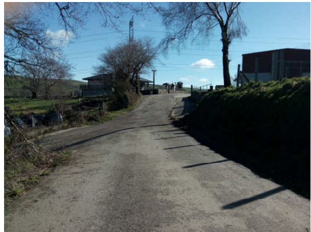
VISTA XERAL CARA O PUNTO DE INICIO DA ACTUACIÓN PROXECTADA. SOBREANCHO 1ª INTERSECCIÓN
