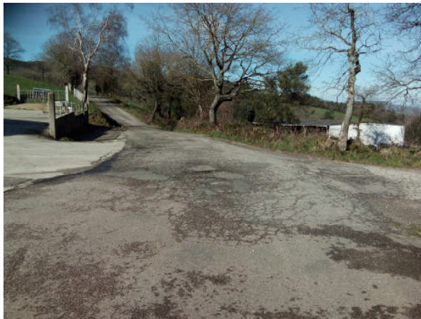
INICIO DO TRAMO DE ACTUACIÓN
