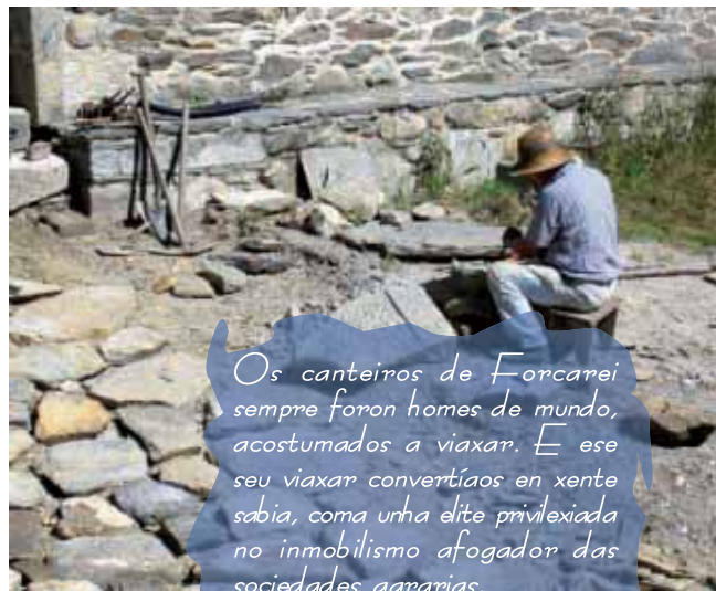
Canteiro picando na pedra
