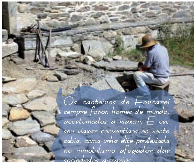
Canteiro picando na pedra
