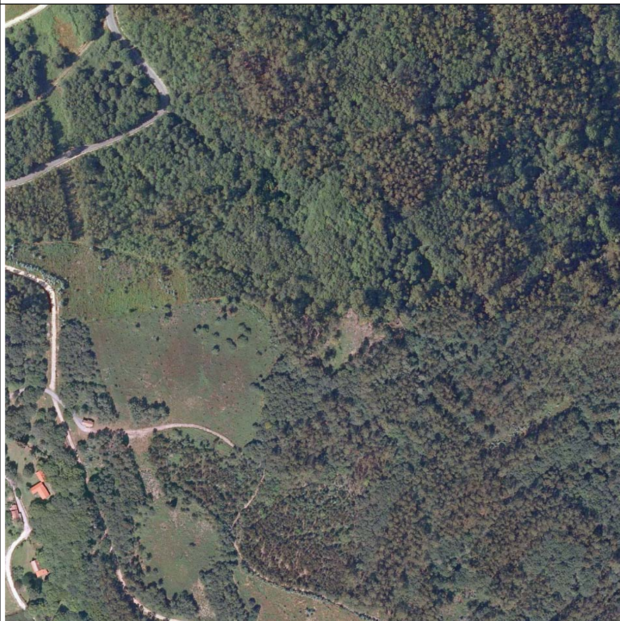
Fotografía aérea de O Sabugueiro.
