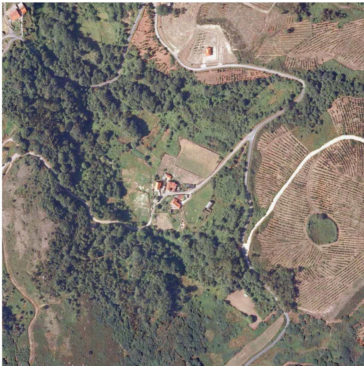
Fotografía aérea de O Pereiral.
