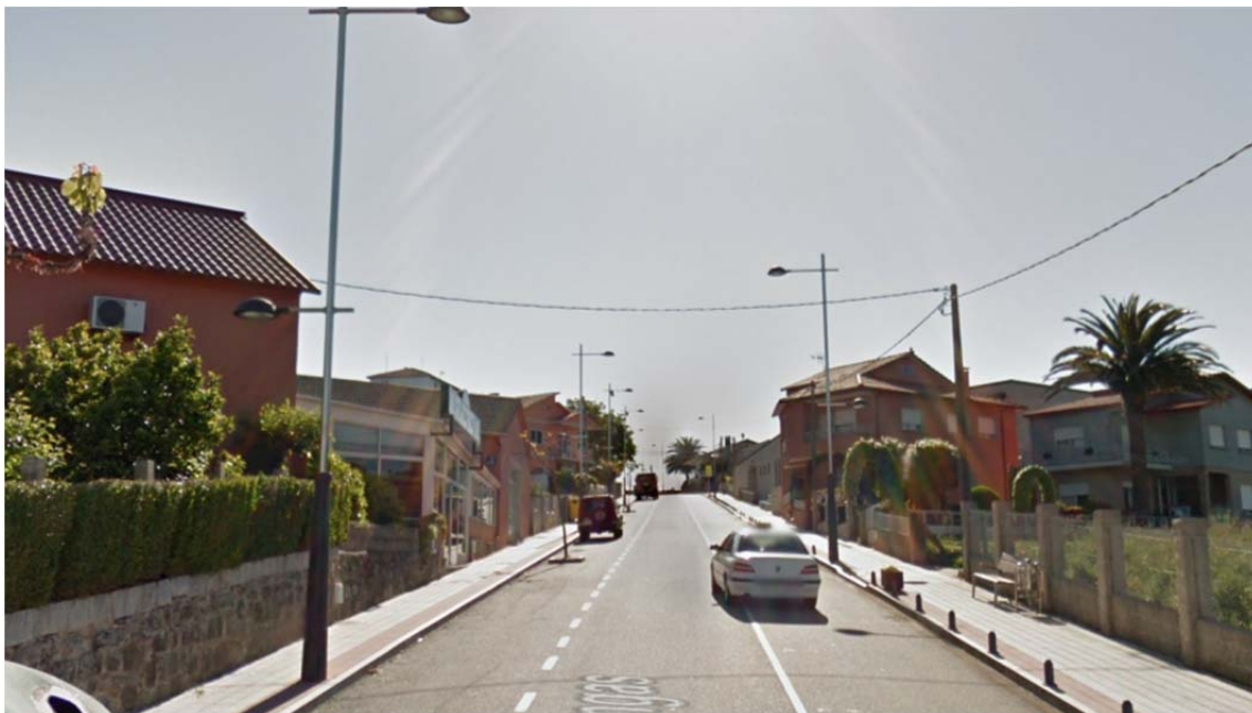
Inadaptación das edificación ó parcelario.
